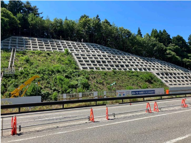
切土③で吹付砕工が完了しました。この後、上部から順番に足場を組んで鉄筋挿入工を進めていきます。
