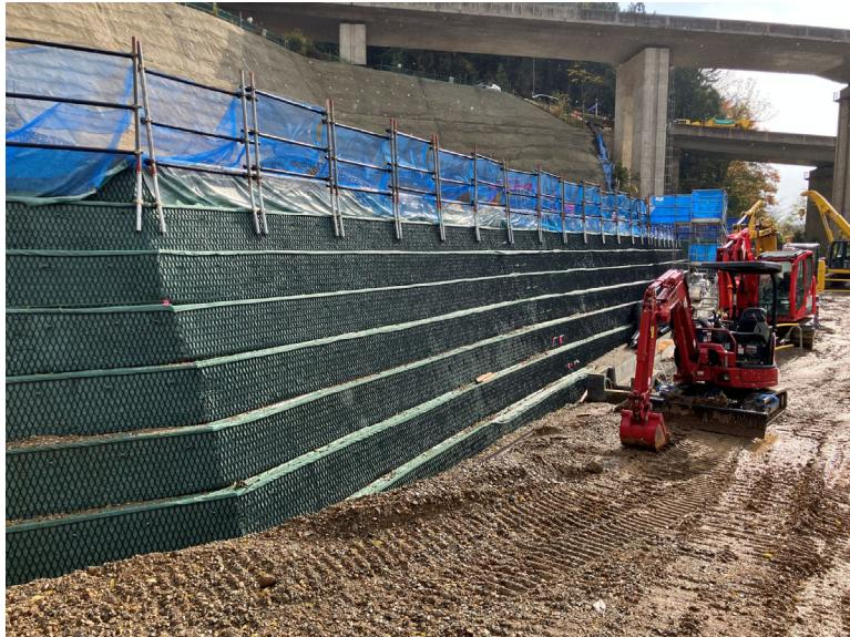
穴水ランプは盛土を行っており、現在は4mの高さまで盛土が上がっております。12月は水平ボーリングの作業を予定しております。大型車両の出入りがありますので、通行の際は工事車両に注意をお願いいたします。
