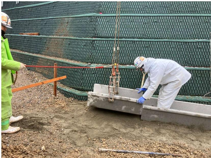
Aランプでは、日頃、目にすることが多い側溝を順次、設置しております。能越道本線からの雨水が、将来的にこちらの側溝に流れれるようになります。また、今後は引き続き、盛土と側溝関係の工事を行なっていきます。
